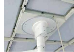
Plafond diffusant équipé de filtres absolus permettant la réalisation de blocs opératoires risque 3 ou risque 4 suivant la norme NFS-90351
